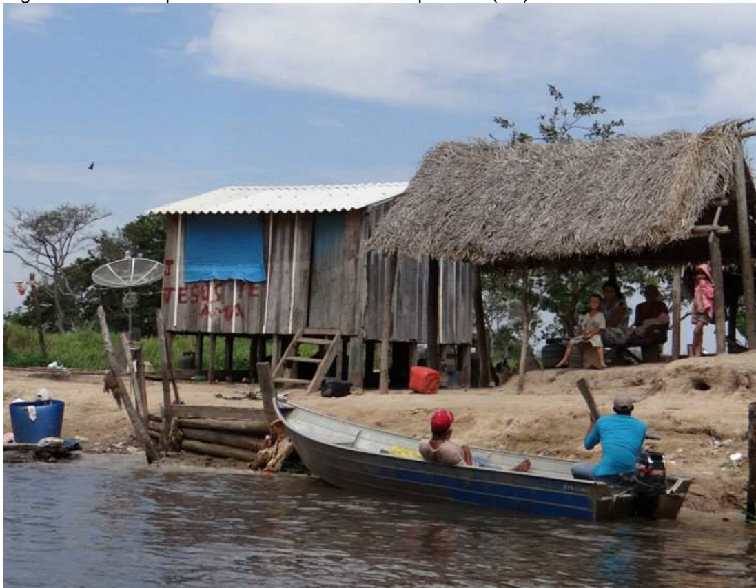
Figura 4.21: Casas pantaneiras construídas sobre palafitas (s/d).
