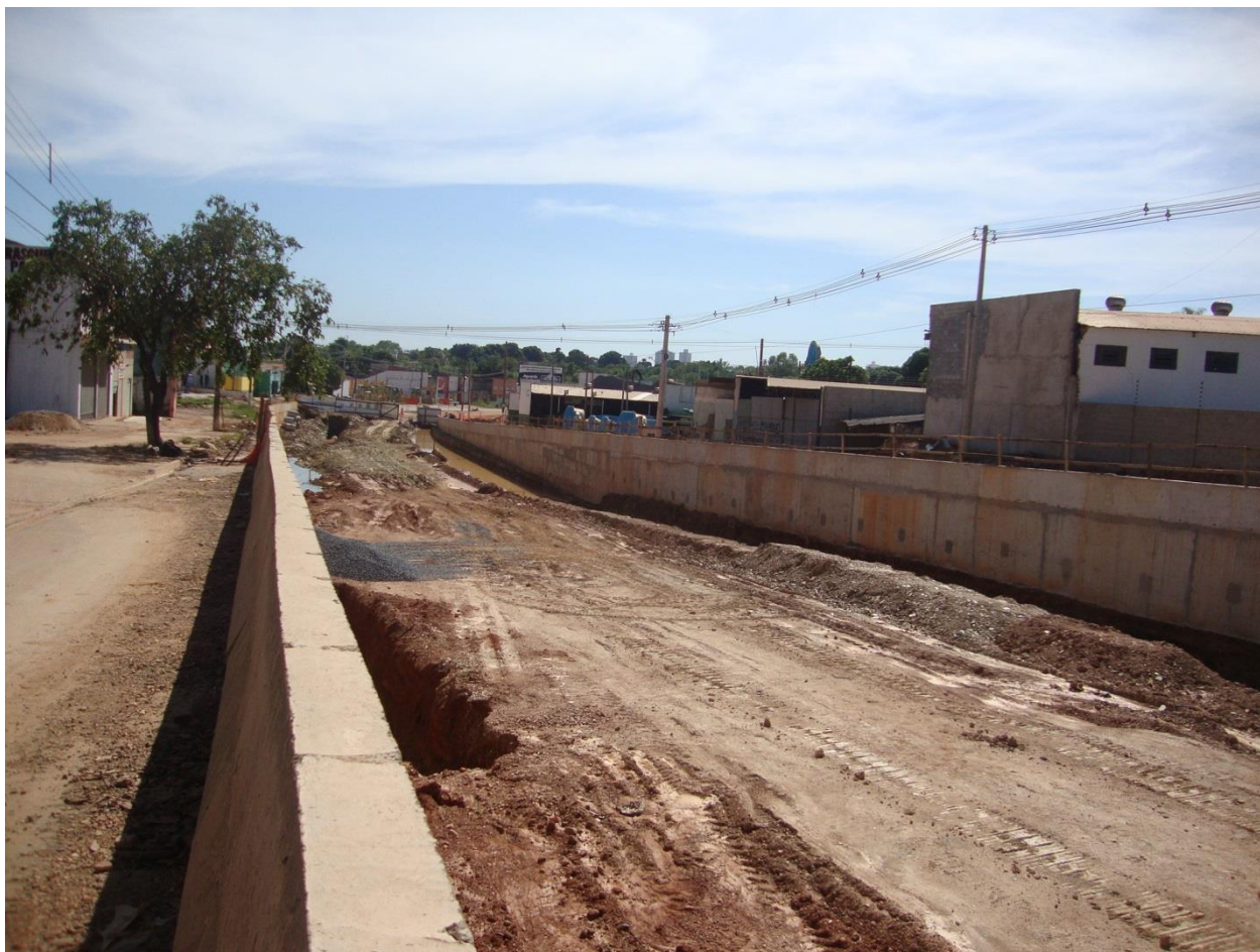
Figura 6: Trincheira na Av. Miguel Sutil em Cuiabá.
