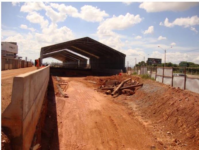
Figura 7: Obras do VLT na av. FEB em Várzea Grande.
