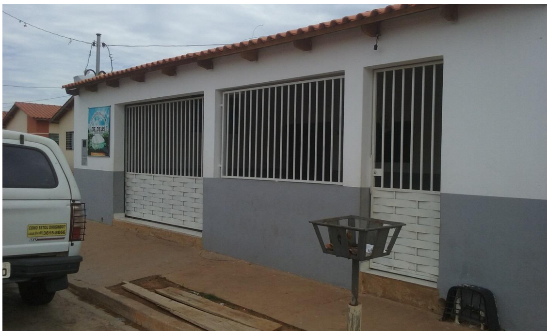
Figura 55: Moradia transformada em Igreja no Bairro Altos do Parque
