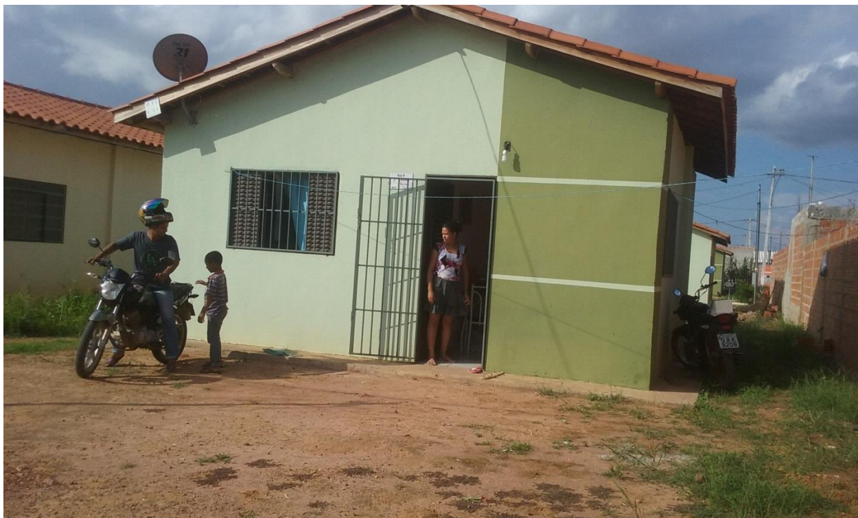
Figura 56: Moradia com grades de proteção nas janelas e Portas
