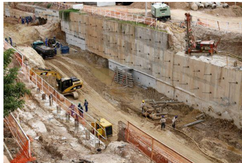
Figura 8: Obras da Av. Miguel Sutil em Cuiabá.
