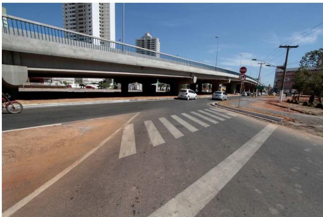
Figura 19 e 20: Elevado da UFMT na Av. Fernando Correa da Costa, 2014
