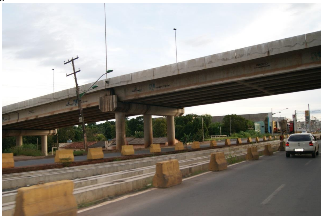
Figura 37: Viaduto criado na Av. da FEB em Várzea Grande em cima das casas dos moradores do Bairro da Manga-VG
