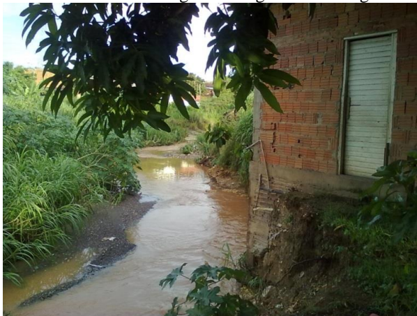
Figura 42: Moradia construída no Bairro Pedregal às margens do Córrego do Barbado
