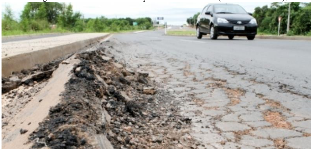
Figura 15: Obras da Avenida Arquimedes Pereira Lima (Estrada do moinho), 2014.
