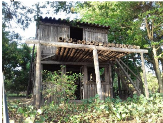
Figura 79- Área administrativa abandonada
