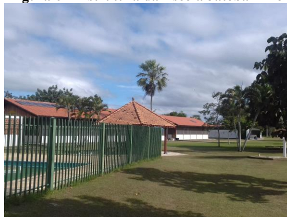
Figura 61- Estrutura da Escola Jatobazinho
