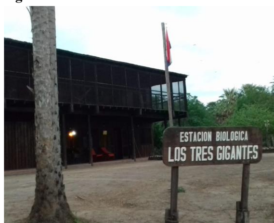
Figura 81- Área administrativa da Estación
